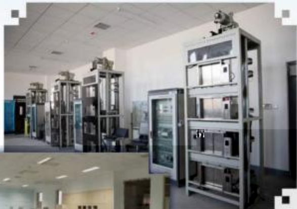
智能电梯安装调试 维护训练场所
